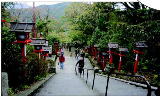
本殿金堂に至る急峻な階段
